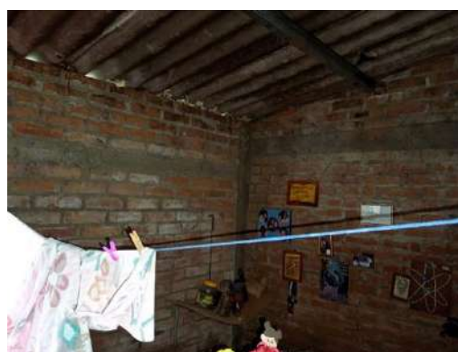
Habitación 2 de vivienda ladrillo macizo
