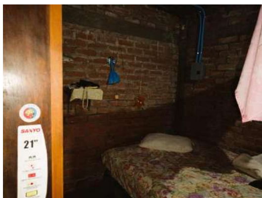
Habitación 1 de vivienda ladrillo macizo
