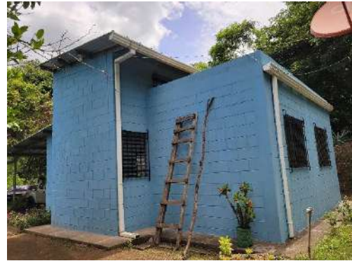
Fachada posterior vivienda bioclimática.
