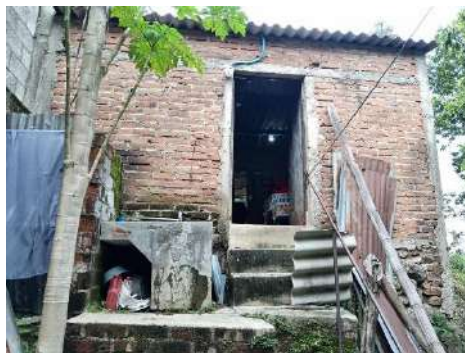
Fachada posterior vivienda ladrillo macizo
