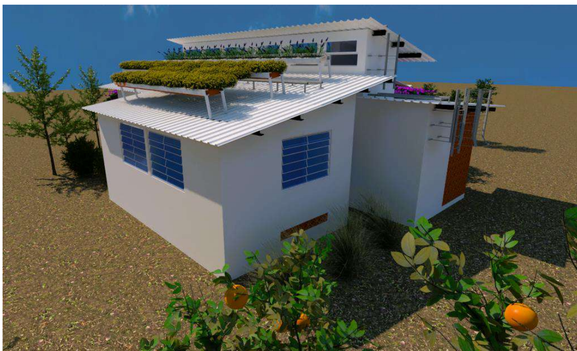
Imagen 56: Vista de estructuras de techo verde.
