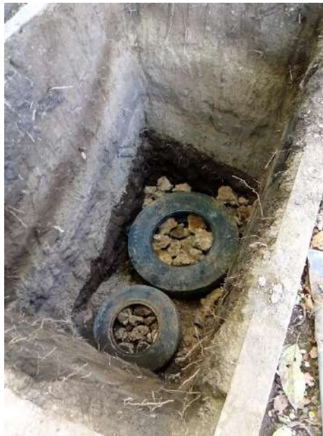
Imagen 65. Se observa llantas perforadas, las cuales se colocan una encima de la otra para drenar el agua.
