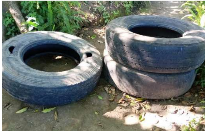
Imagen 64. Se observa llantas perforadas, las cuales se colocan una encima de la otra para drenar el agua.
