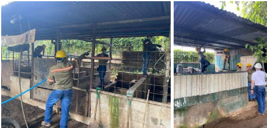
Estudiantes de la carrera Técnico en Ingeniería Eléctrica instalando tuberías y cableado eléctrico.
