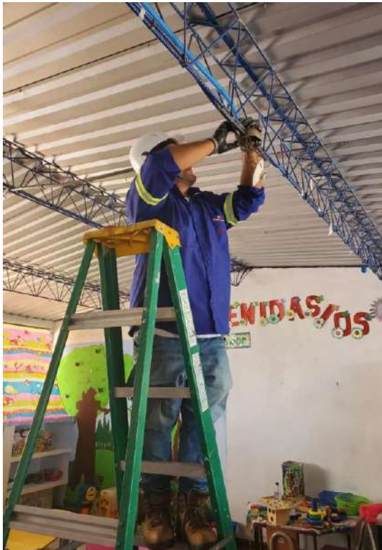
Estudiantes de la carrera Técnico en Ingeniería Eléctrica instalando circuitos derivados de luces y tablero eléctrico.
