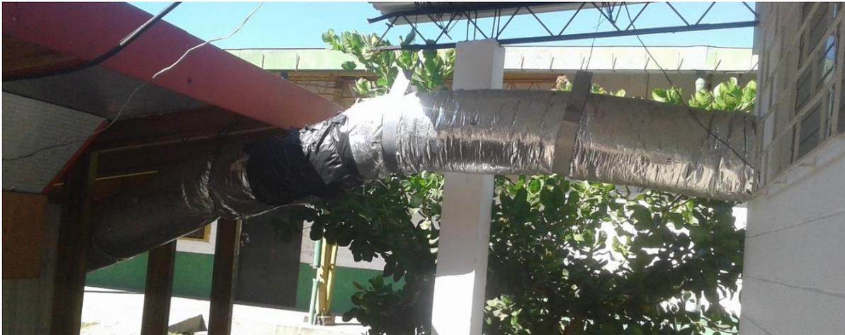
Fig. 15 ducto principal del sistema colector de calor.
