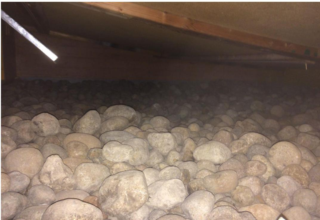
Fig. 14 cámara colectora de calor (interior, vista de las piedras).
