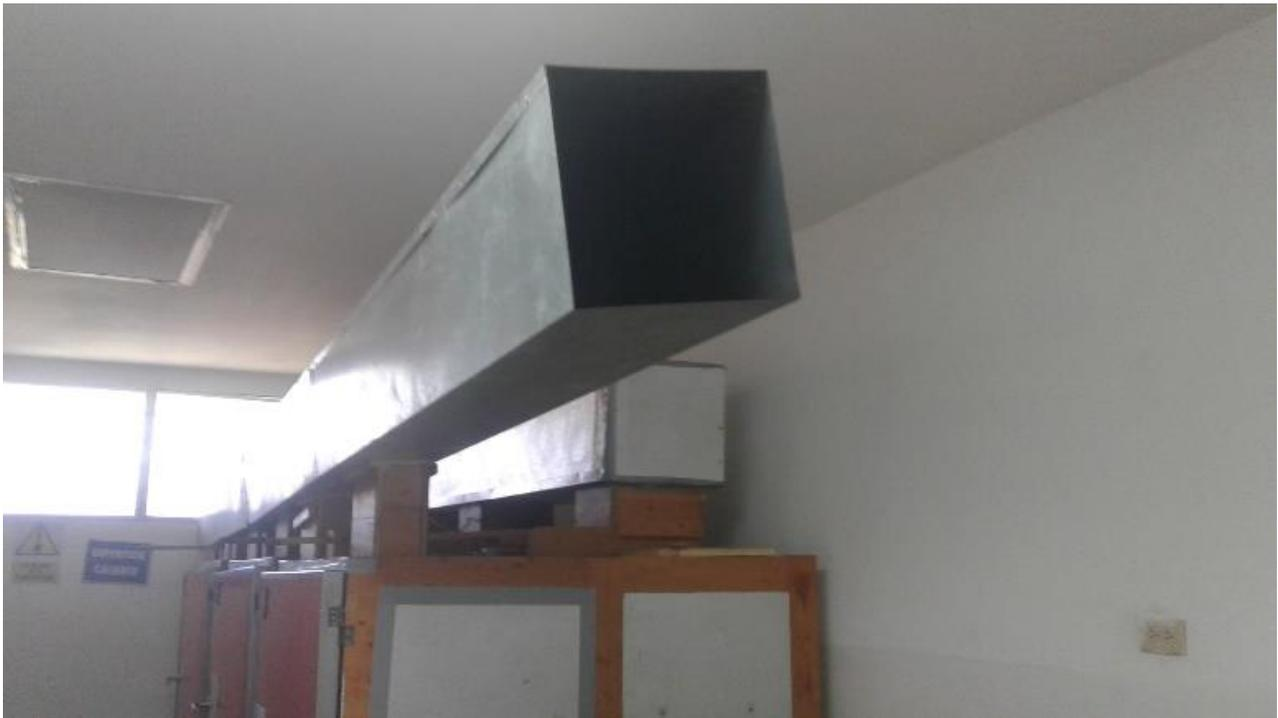
Fig. 30 Vista de los ductos de entrada de aire caliente y salida de aire húmedo de los hornos
