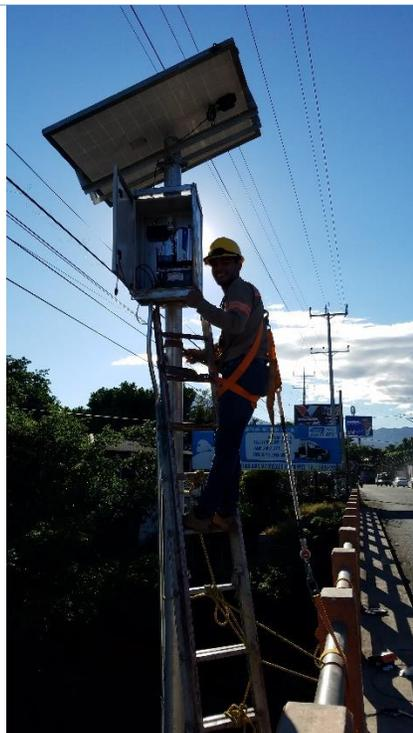
Conexión final del sensor y dispositivos para el suministro eléctrico en la caja de control.
