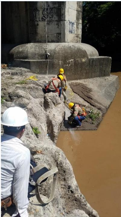
Apertura de franja para la protección del cable de comunicación entre el sensor y la RTU.
