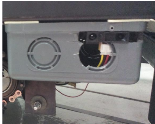
Fig. 30: Sensor IR montado en AGV
