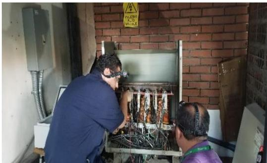
Instalación del medidor ACCUENERGY
