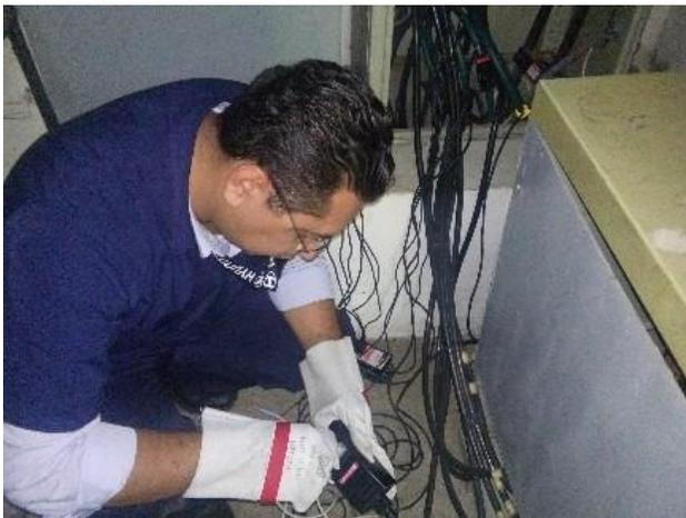
Mediciones en transformador seco para verificar el cumplimiento de las normas.
