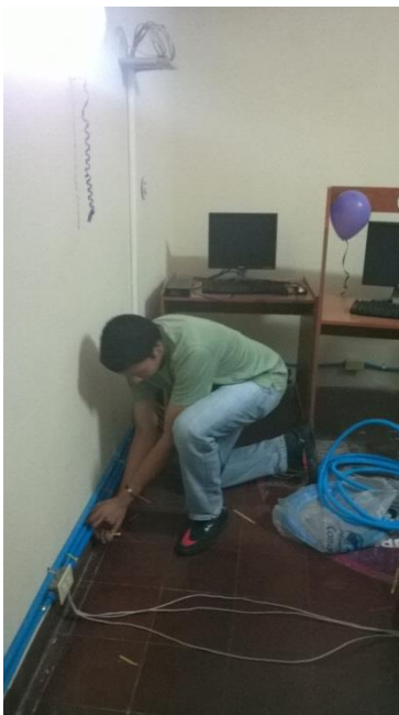
Estudiante instalando canaletas para la red de datos
