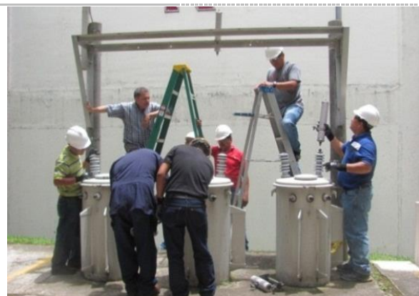
Taller práctico: "Mantenimiento de Subestaciones Eléctricas".
