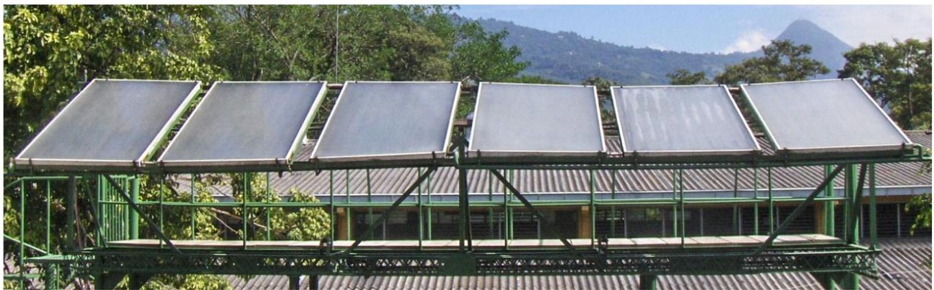
**Plataforma con el sistema de colectores solares fototérmicos instalados para la Cafetería Escuela de ITCA-FEPADE**
