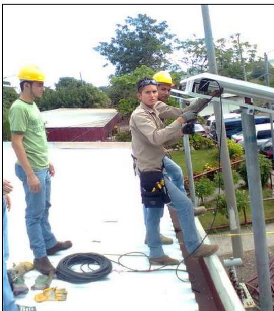
ESTUDIANTES DEL CENTRO REGIONAL INSTALANDO CELDAS SOLARES FOTOVOLTAICAS PARA EL NUEVO LABORATORIO
