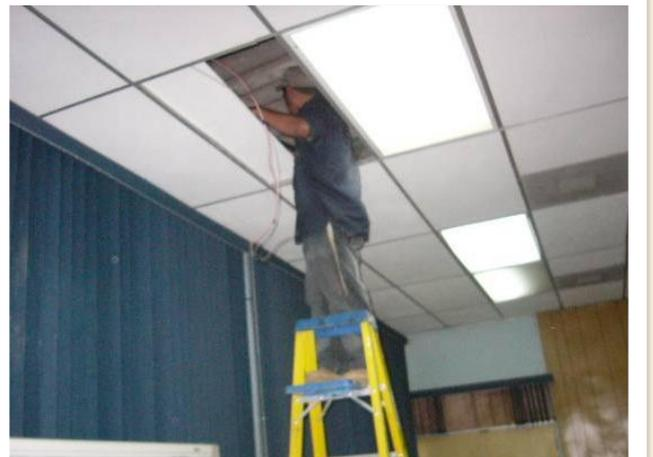
**Estudiantes de ITCA-FEPADE instalan la red eléctrica y nodos de conexión a la red LAN de los lectores RFID**
