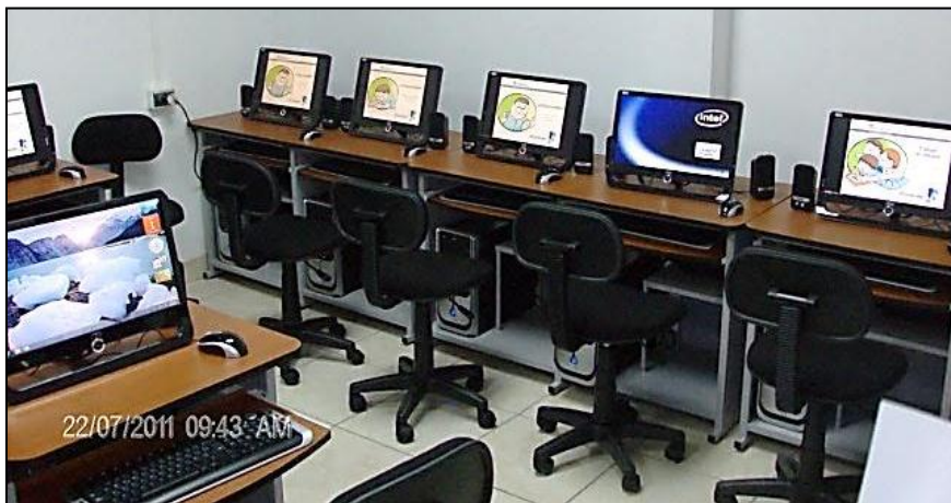
Instalaciones eléctricas bajo norma efectuadas en el centro de cómputo del Centro Escolar Cantón Lourdes.
