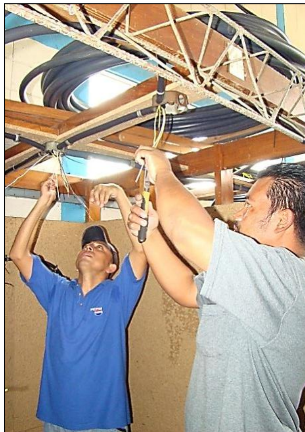
Participantes realizando instalaciones eléctricas.
