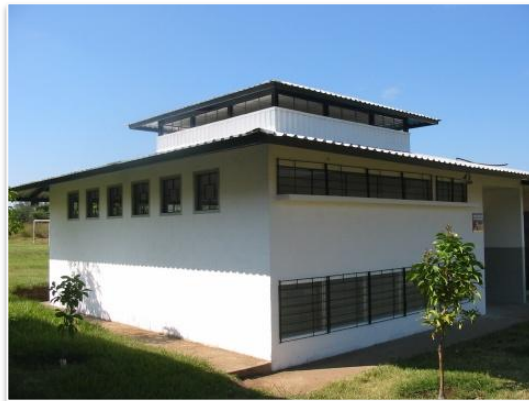
Fotografía 2: Aula C101 después de la remodelación
