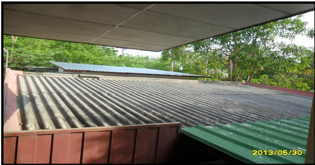
Figura 53. Servicios sanitarios con Lámina de Asbesto Cemento.
