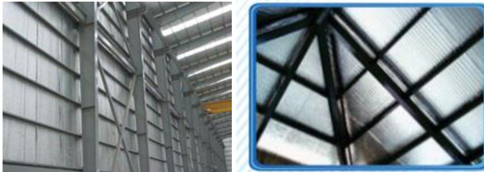
Figura. 39 Aplicación del aislante térmico reflectivo en techos y paredes.
