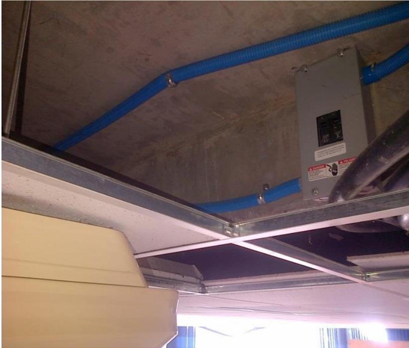
**Fig. 38. Protecciones de aire acondicionado**
