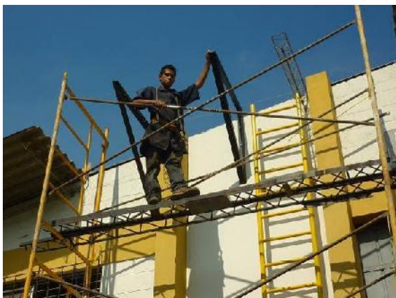
Fig. 12. Instalación de soportes en canasta de trabajo
