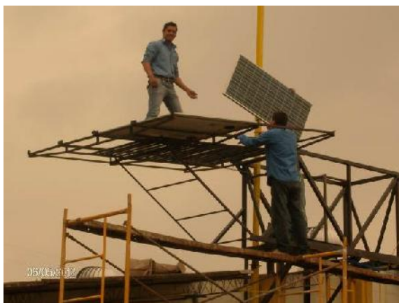
Fig. 16. Estudiantes instalando los paneles fotovoltaicos
