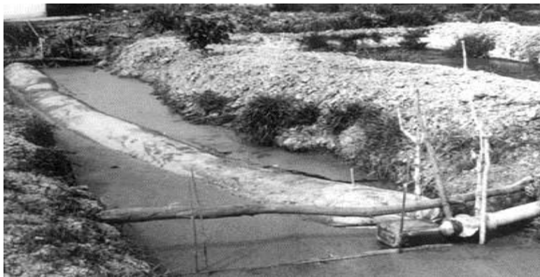
Figura # 6, Biodigestor de estructura flexible.
