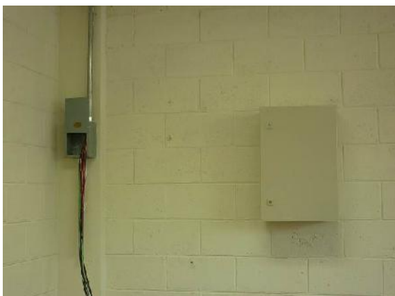
Fig. 18. Panel de control en proceso de instalación
