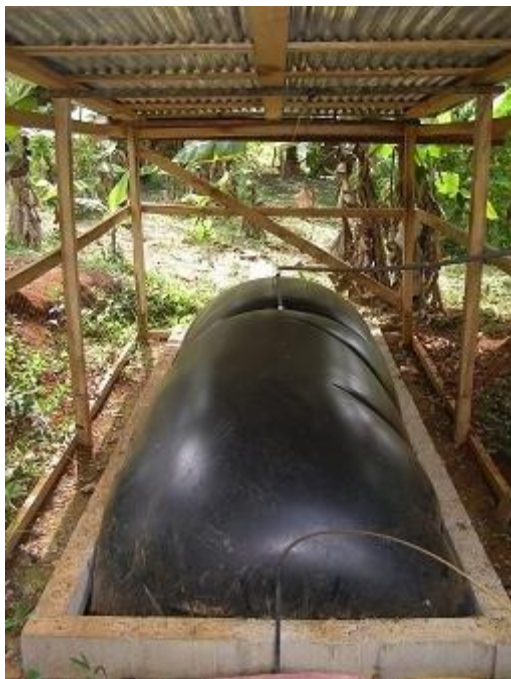
Figura # 5, Biodigestor de estructura flexible, bioreactorcrc.wordpress.com
