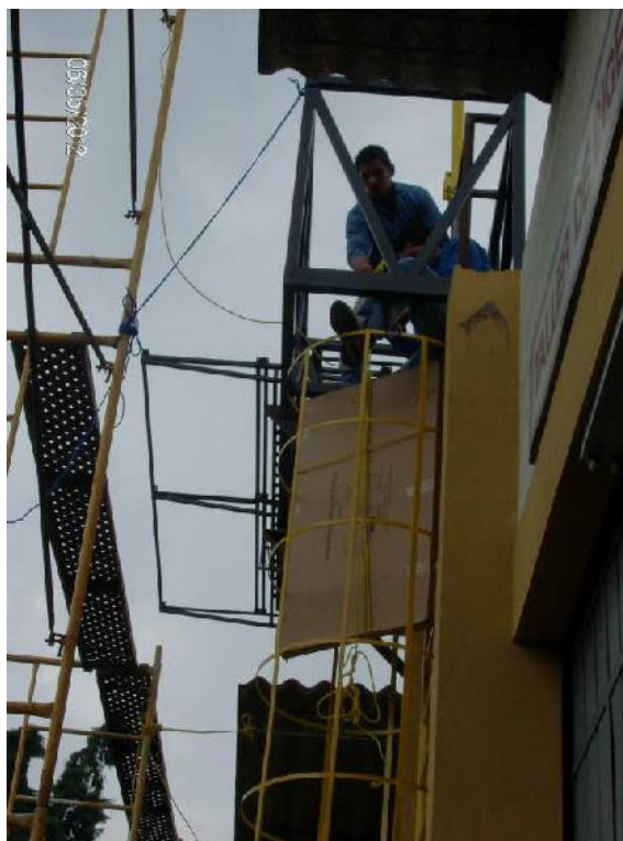
Fig. 15. Estudiantes subiendo los paneles Fotovoltaicos
