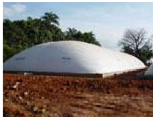
Figura # 4, Biodigestor de estructura flexible, bioreactorcrc.wordpress.com
