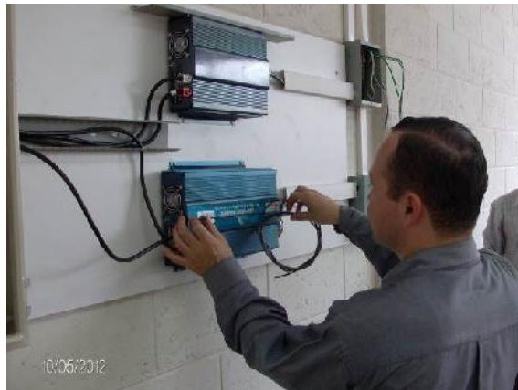
Fig. 19. Instalación de inversores
