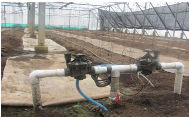
Fig. 3. Electroválvulas instaladas para cada zona del invernadero.
