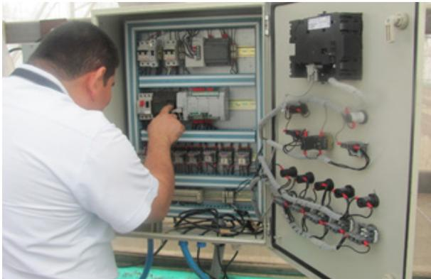
Fig. 2 PLC y sistema para control de riego automatizado del invernadero.
