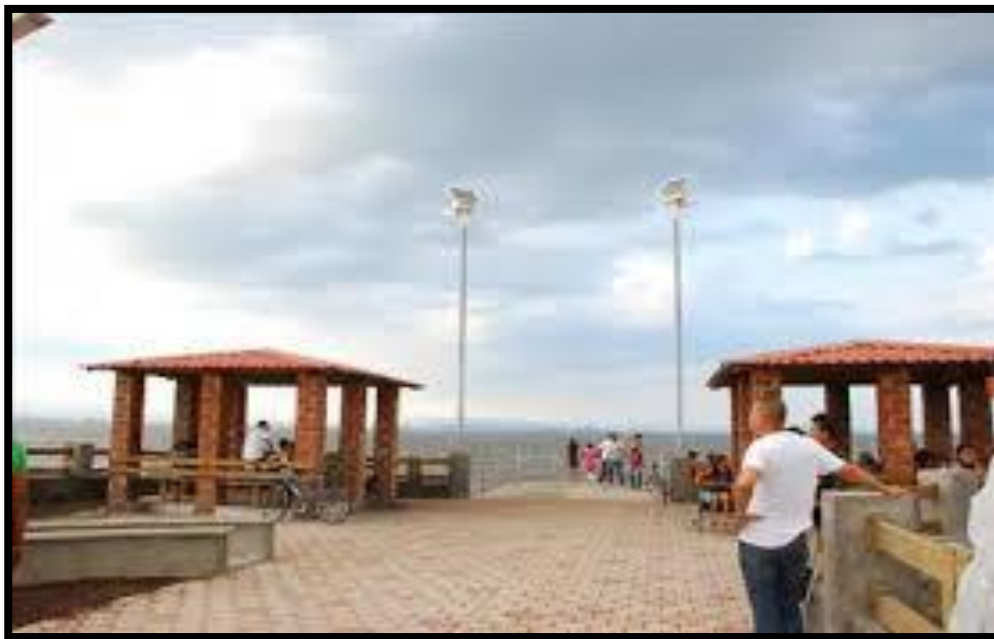
Ilustración 3. Construcción de nuevo muelle municipal Los Coquitos.
