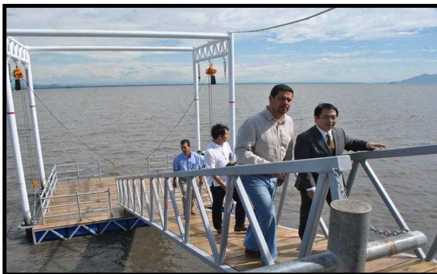
Ilustración 4. Construcción de nuevo muelle flotante municipal Los Coquitos.
