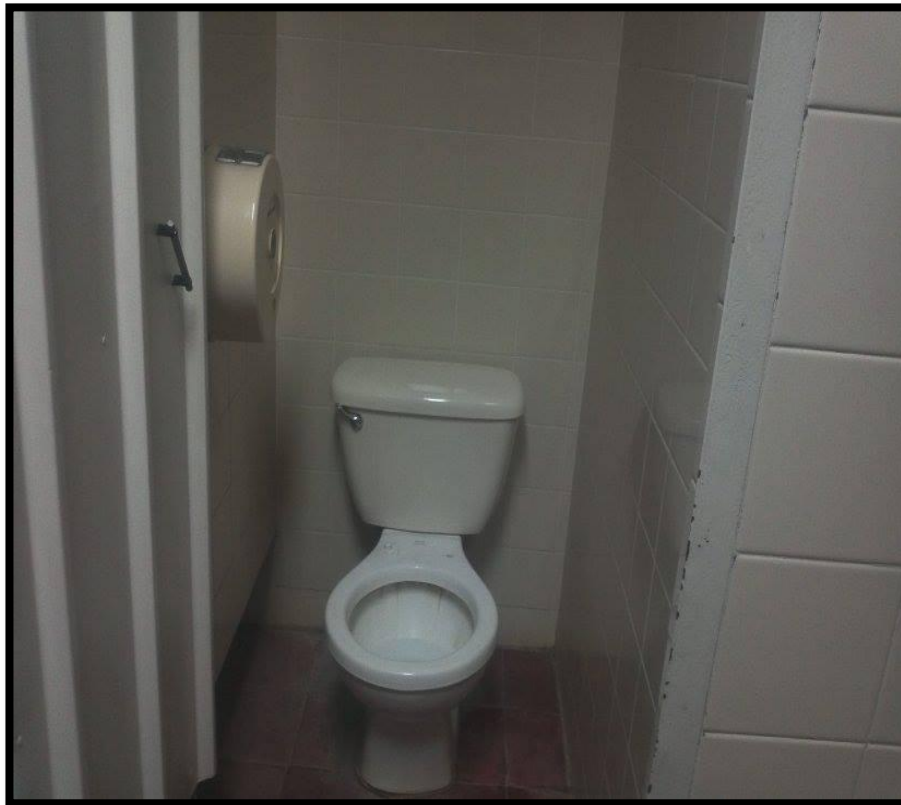
Figura 79. Estado actual de los sanitarios
