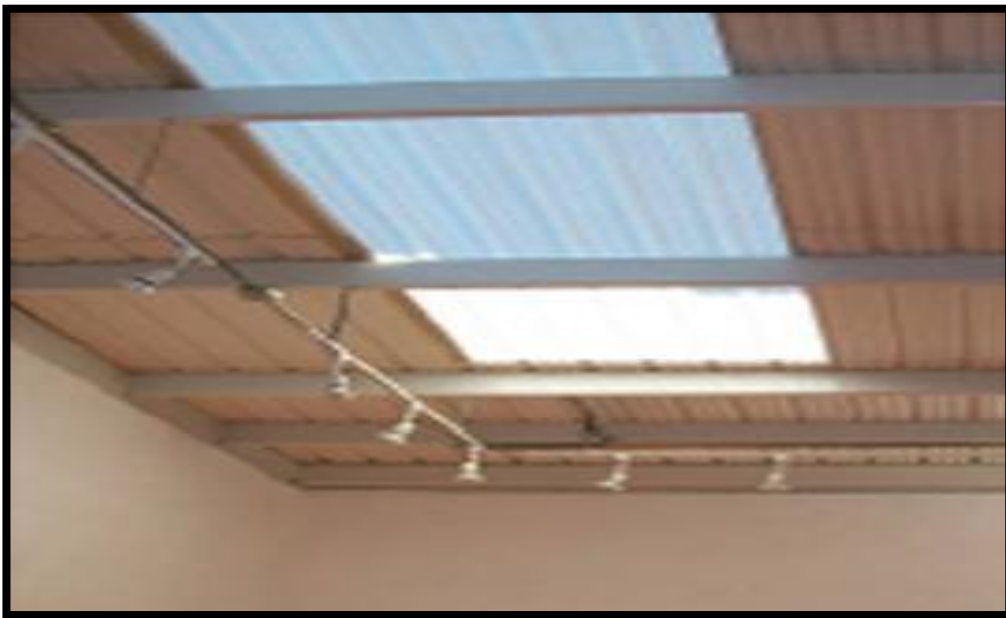
Figura. 30 Cubierta con lámina traslucida.
