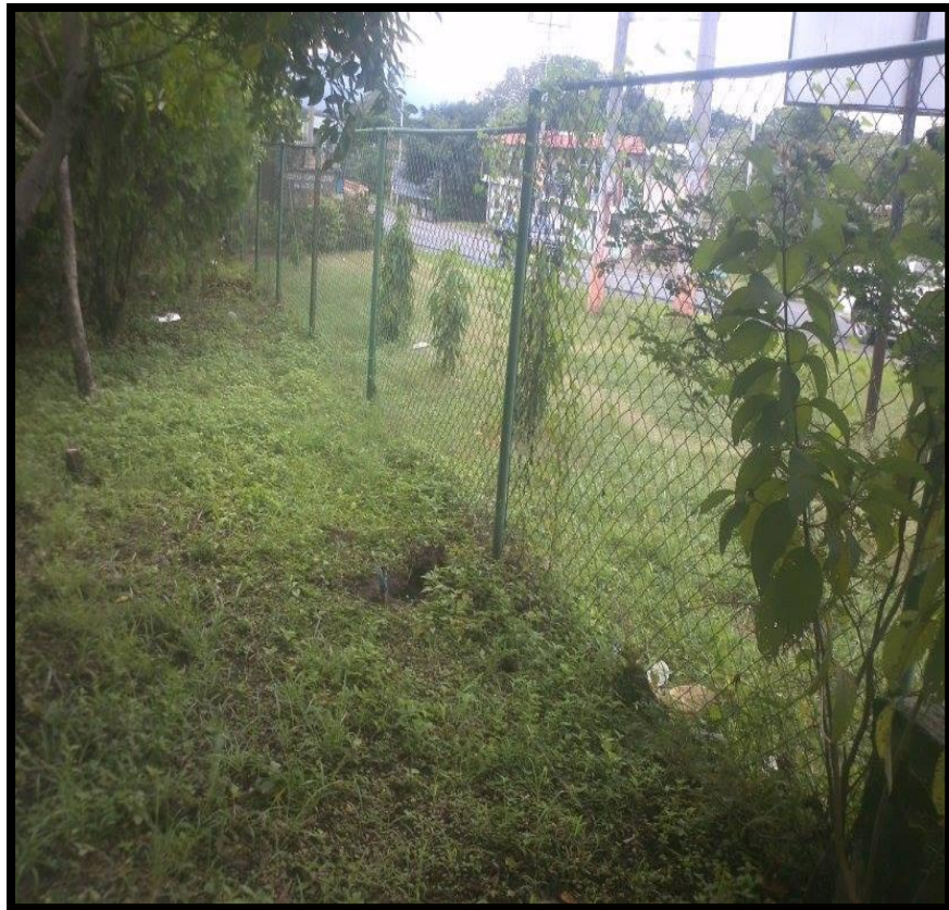
Figura 69. Estado actual del muro.
