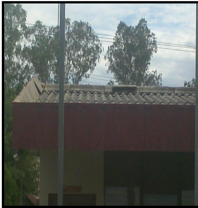
Figura 67. Estado actual de los techos
