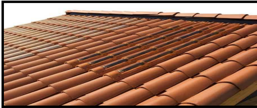
Figura. 32 Techo con teja de barro .
