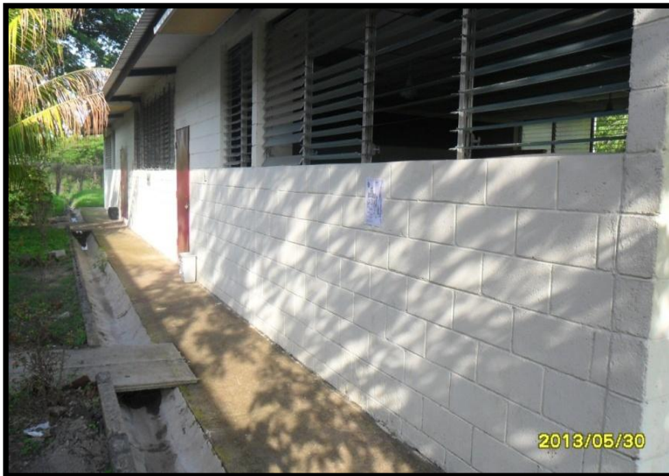
Figura 51. Las aulas 7 y 9, y de mantenimiento fueron construidas recientemente y fueron construidas con bloque de concreto.
