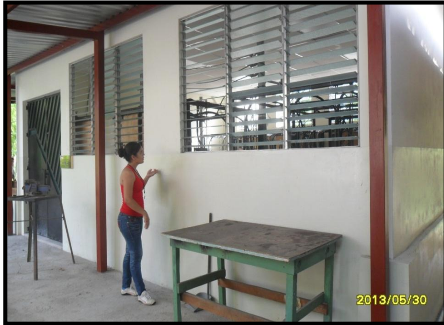
Figura 52. El taller de Eléctrica construido a base de DenGlass y cubierto por lámina Zinc Alum.
