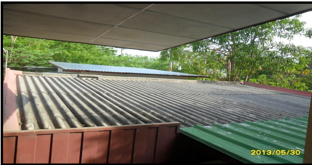
Figura 53. Servicios sanitarios con Lámina de Asbesto Cemento.
