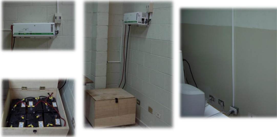
Figura ¡Error! No hay texto con el estilo especificado en el documento.-6. Sistema de alimentación ininterrumpida de energía eléctrica del proyecto.
