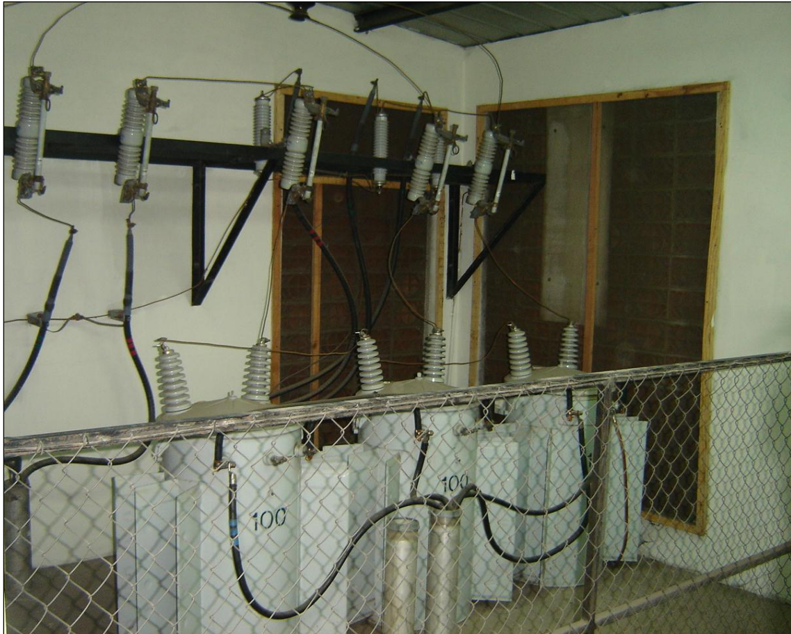
Figura ¡Error! No hay texto con el estilo especificado en el documento.-1. Banco de transformadores en la subestación a monitorear
