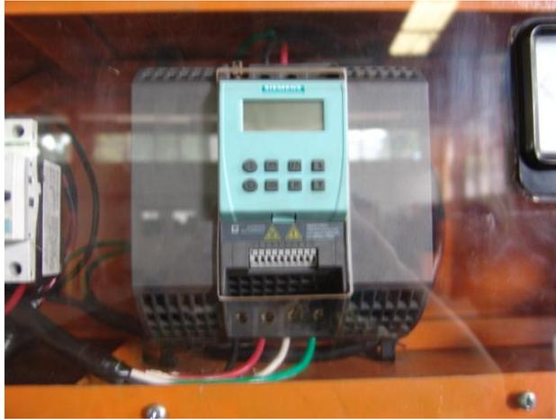
**Figura 17. Fotografía del Variador de Frecuencia Sinamics G110**
