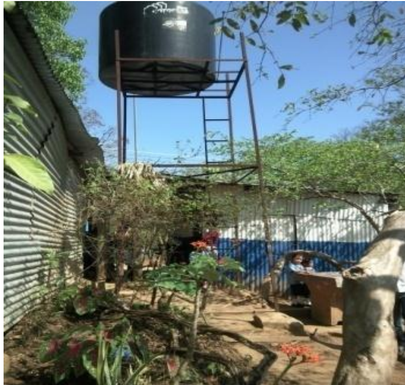
FOTOGRAFÍA No. 11 TANQUE ELEVADO AGUA POTABLE
