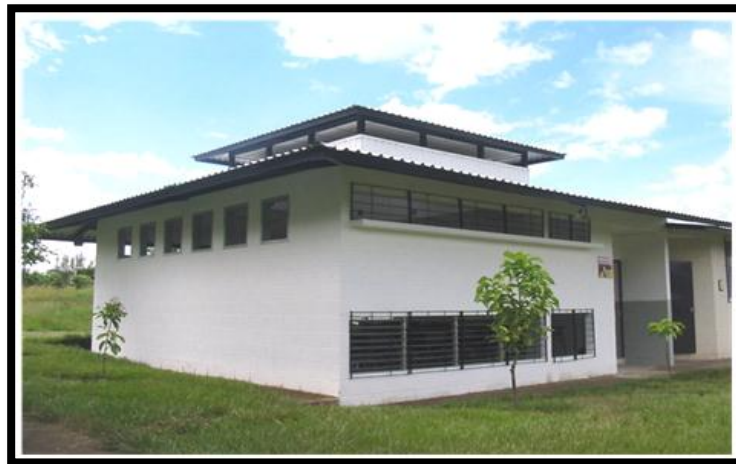
FOTOGRAFÍA No.3 AULA BIOCLIMÁTICA CONSTRUIDA EN ITCA FEPADE SANTA ANA
