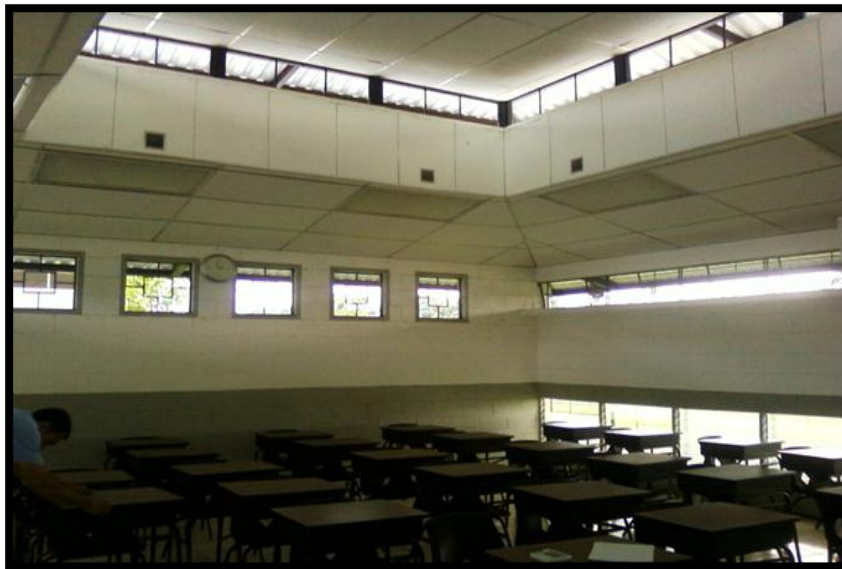
FOTOGRAFÍA No. 4 VISTA INTERIOR DEL AULA BIOCLIMÁTICA EN ITCA-FEPADE SANTA ANA
