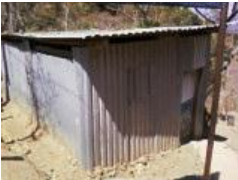
FOTOGRAFÍA No.7 AULA CON PAREDES DE LÁMINA
