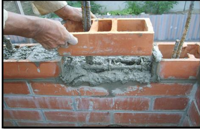
FOTOGRAFÍA No. 5 COLOCACIÓN DE BLOQUE DE BARRO
