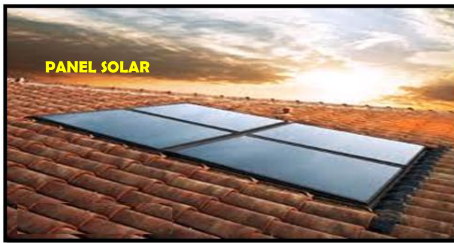
IMAGEN No. 4 PANELES SOLARES SOBRE UN TECHO DE TEJA
